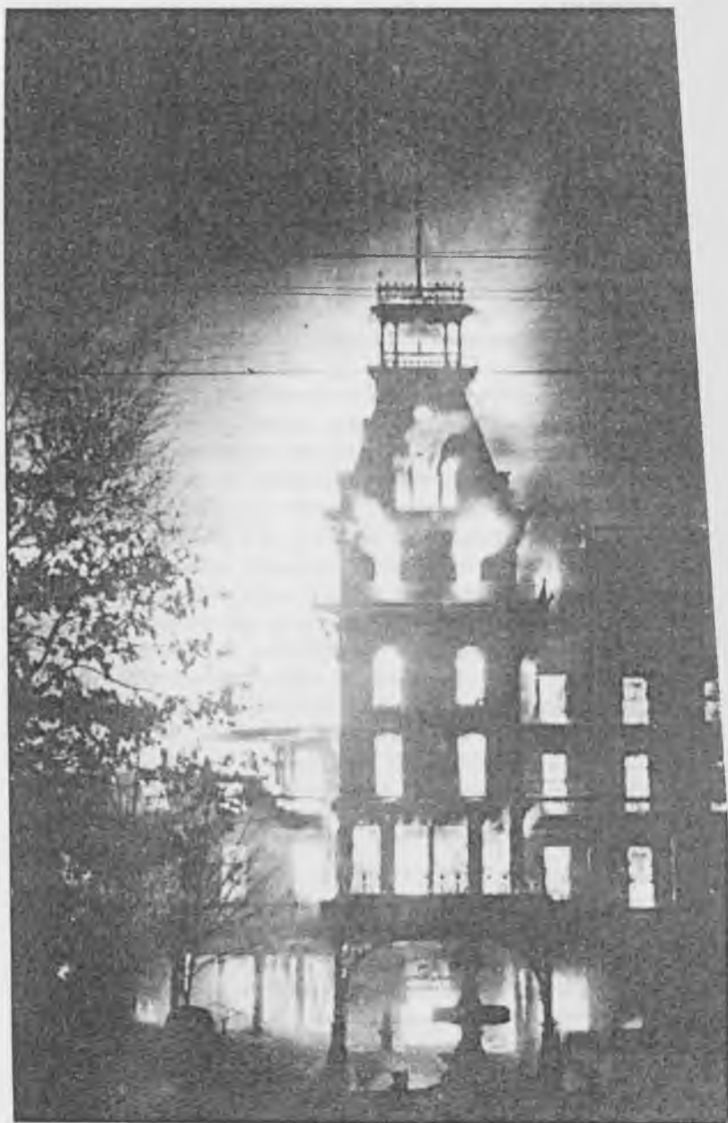
Llamaradas de fuego de origen desconocido transformaron el inmenso hospital de Battle Creek en escombros, ruinas y cenizas.
